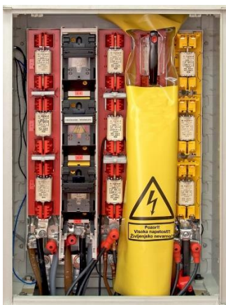
Zaščitno izolirno pregrinjalo za NH varovalčne ločilnike
